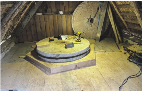
I november 2025 blev der lagt nyt plankegulv og monteret møllesten. Opgaven blev udført af Samsø Tømrer og Bygningsrestaurering ved møllebygger Michael John Jensen. Foto: Foreningen Bornholm
