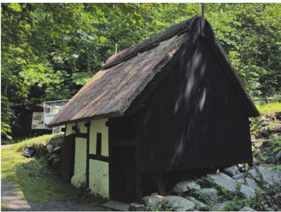
Den 19. juli 2025 blev reparation af langhalmstagnet afsluttet. Opgaven blev udført af Finsen Strå fra Rønne. Foto: Foreningen Bornholm
