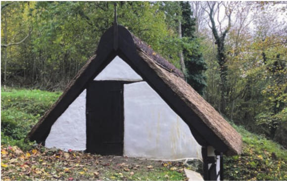
Den 17. oktober 2025 blev retablering af lerklinet væg afsluttet. Opgaven blev udført af HJB Byggeforretning fra Rønne. Foto: Foreningen Bornholm
